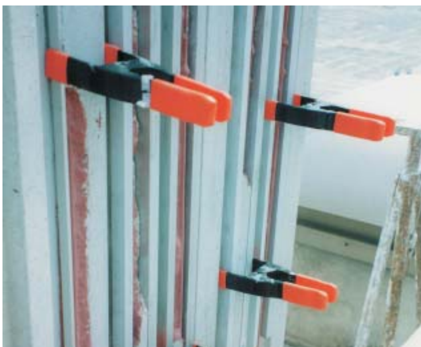
Particolare del sistema di cassetta ideato per ripristinare le modanature dei pannelli
