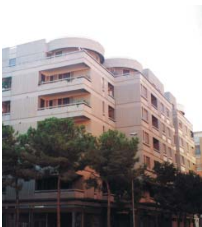
Veduta d'insieme dell'immobile oggetto dell'intervento
