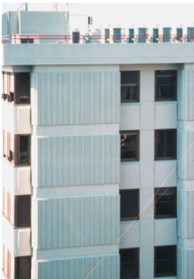
Veduta di una facciata dopo l'intervento di ripristino
